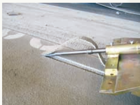
Entfernen von OS 11 Removing OS 11 Enlèvement du OS 11
