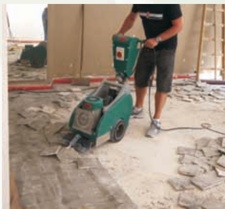
Entfernen von Fliesen Removing ceramic tile Enlèvement du carrelage
