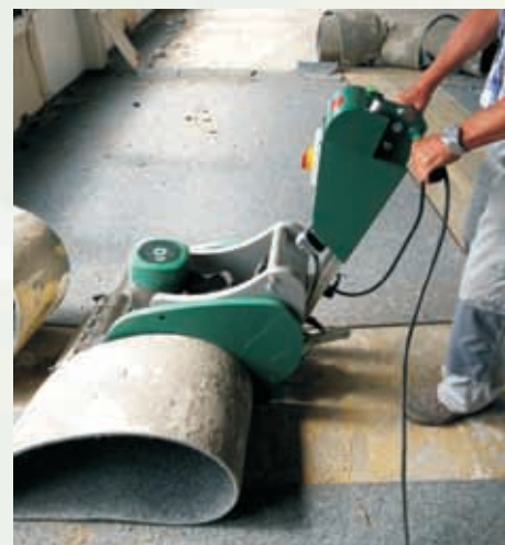
Entfernen von Teppich Removing carpet Enlèvement du tapis
