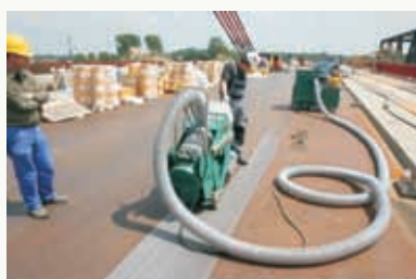
Kugelstrahlen von Stahl Shotblasting of steel Grenailage sur acier
