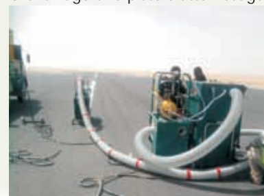
Kugelstrahlen einer Landebahn Shotblasting of a runway Grenailage une piste d'atterrissage
